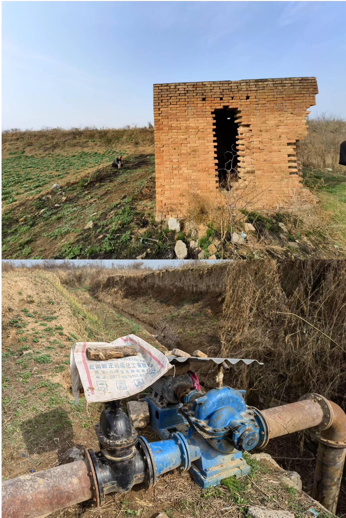
(3) 阳峪镇阳峪村规划建设滴灌工程 600 亩，前期已建水源井
